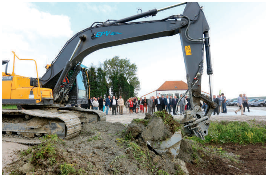
Travaux. Le second plan d'eau devrait être terminé mi-2015.
