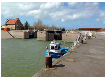
Anticipation. Photomontage de l'écluse Vauban après travaux.
